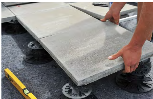
Platten auf Plattenlagern
